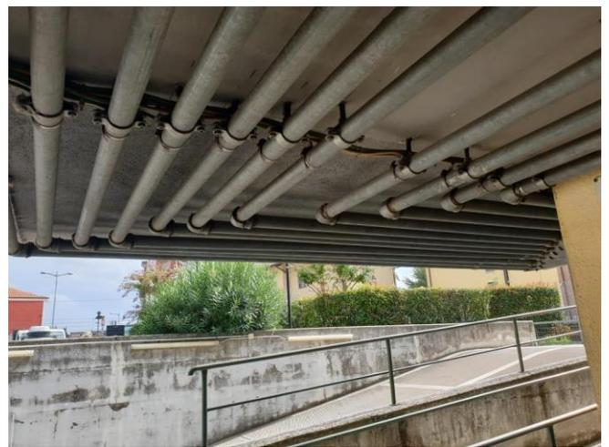
Al fine di permettere l'inserimento dell'isolamento in aderenza al solaio, il progetto prevede di realizzare delle tubazioni gas provvisorie che permettano di alimentare le utenze durante l'esecuzione dell'opera senza discontinuità di servizio ai condòmini.
