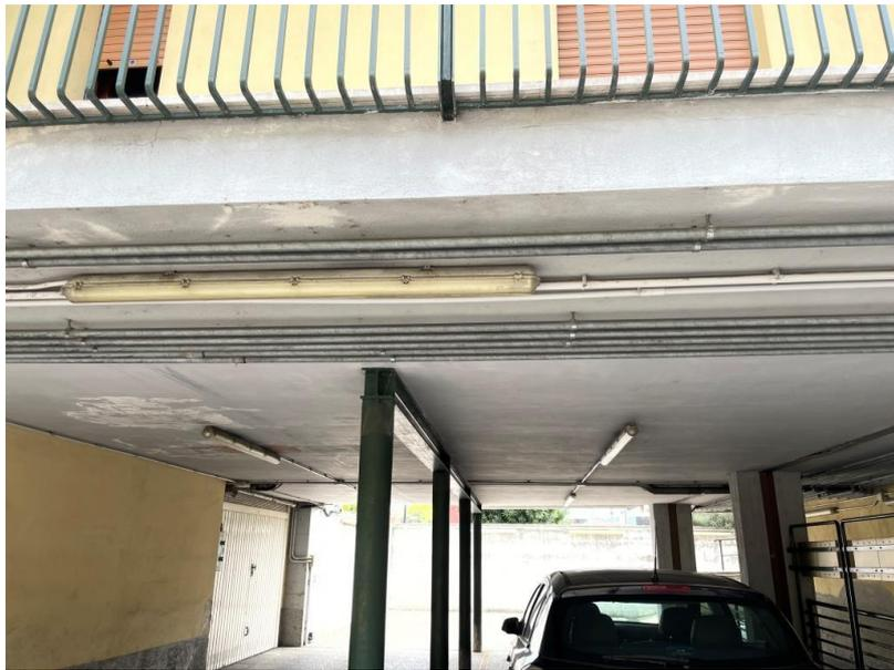
Previa opportuna preparazione (smontaggio delle lampade, pulizia, ecc...) si prevede di realizzare una coibentazione con pannello sandwich costituito da un componente isolante in schiuma polyiso, espansa senza l'impiego di CFC o HCFC, rivestito su entrambe le facce con lo speciale rivestimento Gas Tight triplo strato (riferimento Stiferite GT o similare). Conducibilità termica:  $\lambda D=0,022$  W/mK
