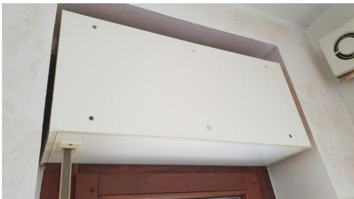
Essi saranno sostituiti con cassonetti realizzati a misura tramite assemblaggio di pannelli termoisolanti pre-accoppiati XPS-Duripanel in modo da adattarsi allo spazio esistente sopra e lateralmente al serramento.
