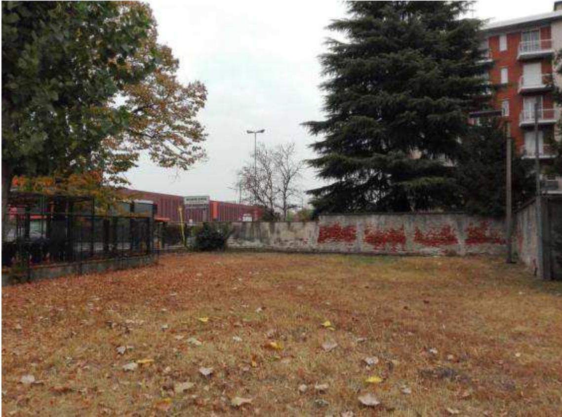
E' previsto il rifacimento della recinzione metallica con sostituzione dell'attuale pannellatura a giorno con nuova pannellatura fissata sul muretto mantenuto e risanato, con nuova copertina in cls. La porzione in muratura cieca verrà completamente risanata, spicconando l'intonaco ammalorato, prevedendo il rifacimento totale con rinzafo, intonaco e tinta di finitura.
