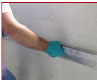
Dopo aver steso il sottofondo e prima della posa di FONOSTOP marca INDEX (o similare), procedere con l'intonacatura delle pareti.
